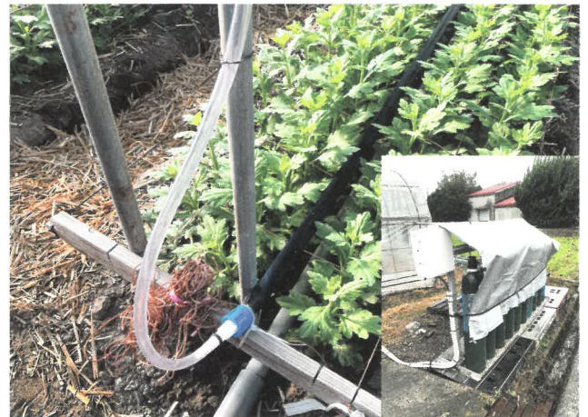
液化炭酸ガス施用システムの設置状況
