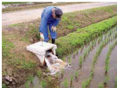
農業用水のパイプライン化
