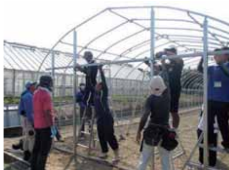
ハウス自力施工研修
