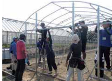
ハウス自力施工研修
