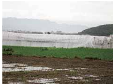
強風により倒壊したハウス
