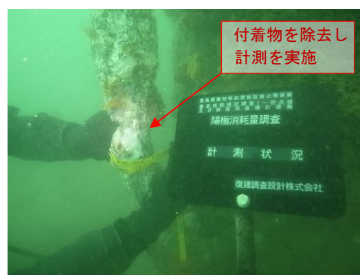
写真2 陽極材の計測状況
