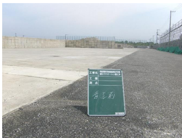
写真 2 着工前 (北→南向き)
