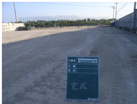
写真 4 完了後 (北→南向き)
