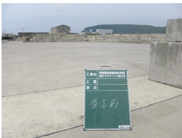
写真 1 着工前 (南→北向き)
