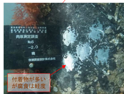
写真⑦ 鋼管杭（搬出入施設_海側西）
