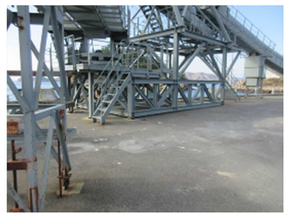
写真③ 搬出入施設
