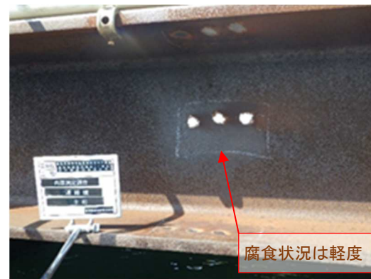
写真② 主桁（連絡橋）
