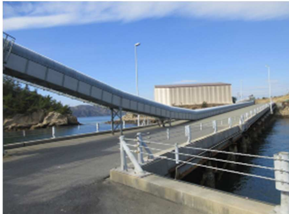
写真② 連絡橋（全景）
