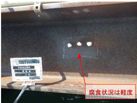
写真 14 主桁の状況（連絡橋）
