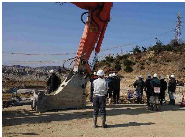
①ピットの解体状況の確認
