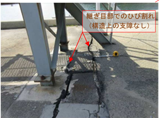
写真⑤ アスファルト舗装面の状況
