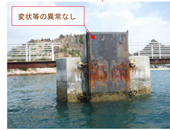
写真⑮ 防舷材状況
