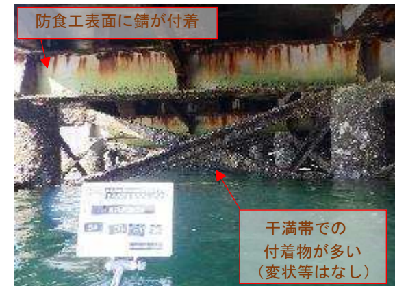
写真⑦ 下部工斜材等 (搬出入施設)
