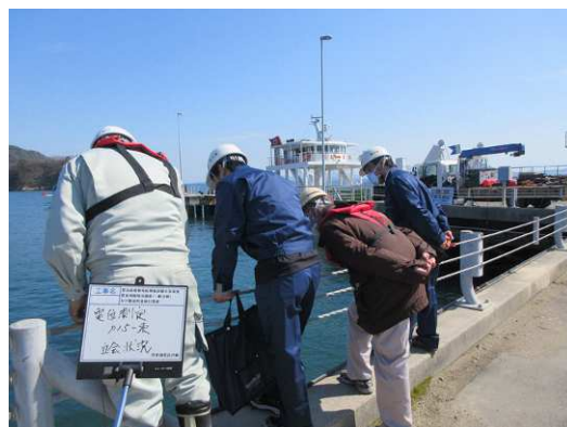
写真13 電圧測定時の立会状況
