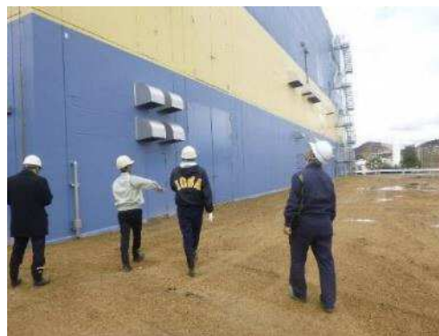
②北棟及び南棟の境界壁修復工事後の状況確認
