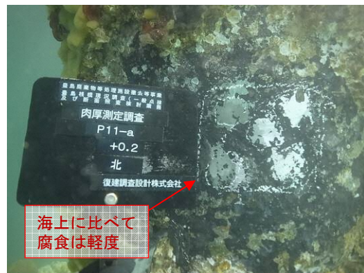
写真 17 鋼管杭の状況（海中部）
