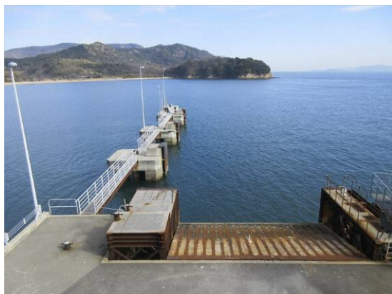
写真1 ドルフィン、歩廊部等の全景
