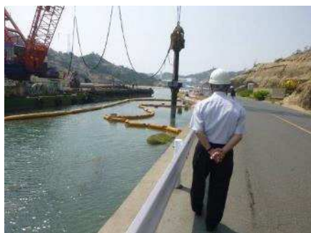
杭撤去作業の確認（北より撮影）
