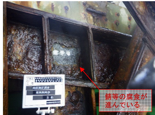
写真 15 主桁の状況（車両乗降部）
