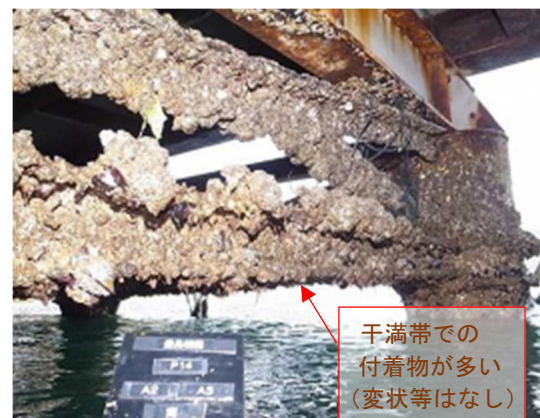
写真⑥ 下部工斜材等 (連絡橋)
