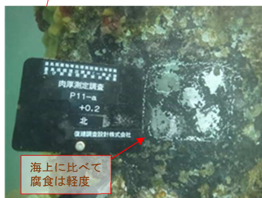
写真⑥ 鋼管杭（連絡橋_海側東）
