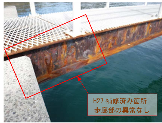
写真⑭ 歩廊部穴あき補修箇所
