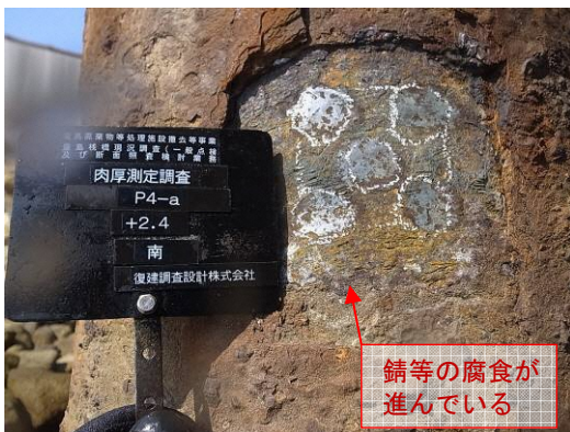
写真 16 鋼管杭の状況（海上部）
