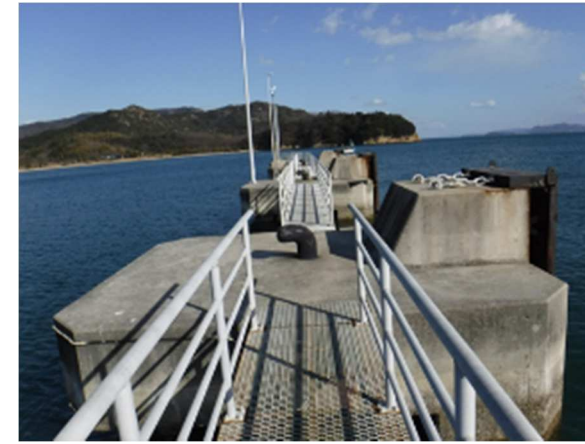
写真⑪ 歩廊部
