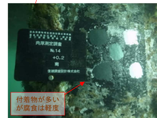
写真⑧ 鋼管杭（車両乗降部_ドック内東）
