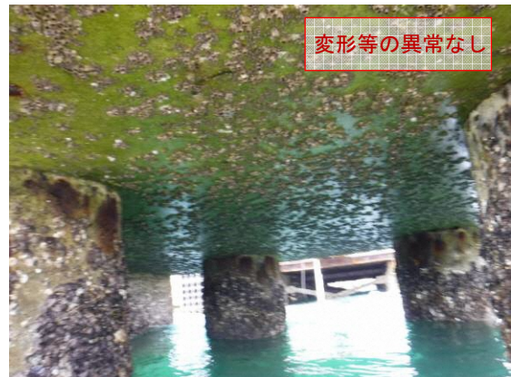
写真8 ドルフィン下面及び鋼管杭の状況
