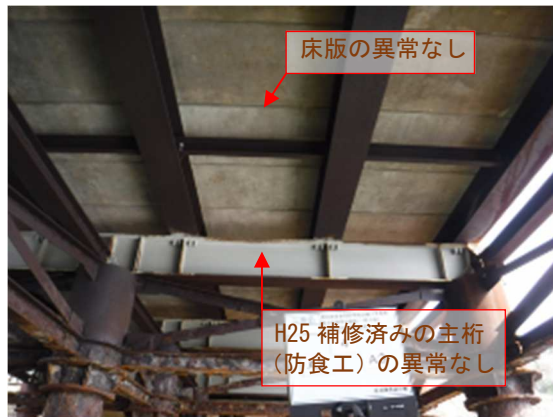
写真① 主桁・受桁 (4, A2A3)
