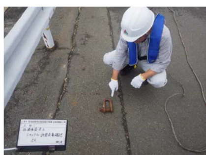
ワイヤースリングの安全確認
