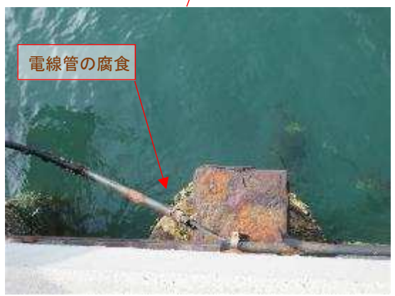
写真⑥ 電線管の状況
