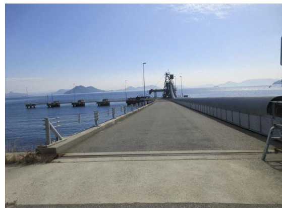
写真2 連絡橋、搬出入施設の全景
