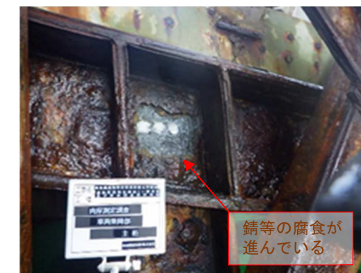
写真④ 主桁（車両乗降部）
