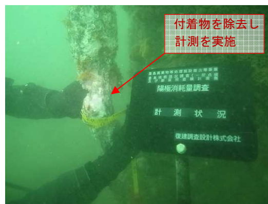
写真 11 陽極材の計測状況
