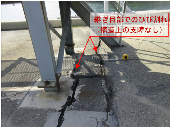
写真3 アスファルト舗装面の状況
