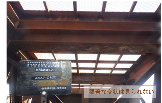
写真④ 車両乗降部上部工
