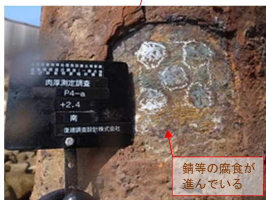
写真⑤ 鋼管杭（連絡橋_陸側西）
