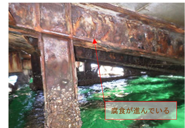
写真⑧ 下部工斜材等 (車両乗降部)
