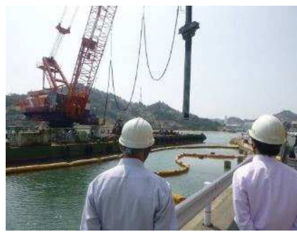
杭撤去作業の確認（北西より撮影）
