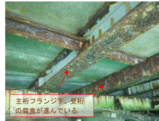
写真③ 主桁・受桁 (搬出入施設)
