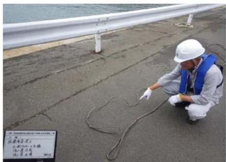
鋼管吊り上げ用のワイヤーの交換
