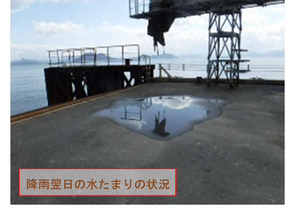
写真⑧ アスファルト舗装部の状況
