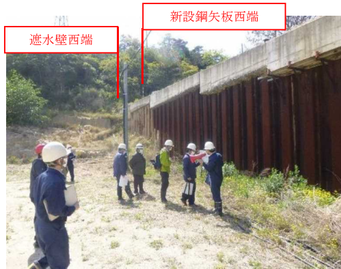
写真3 遮水壁西端部
