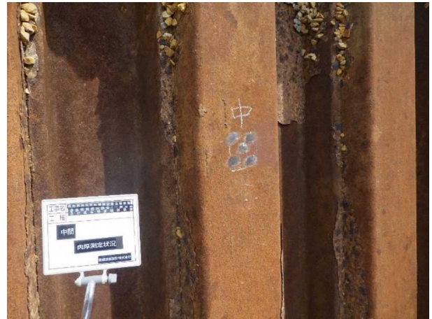
写真4 肉厚測定箇所-研磨後 (中間)
