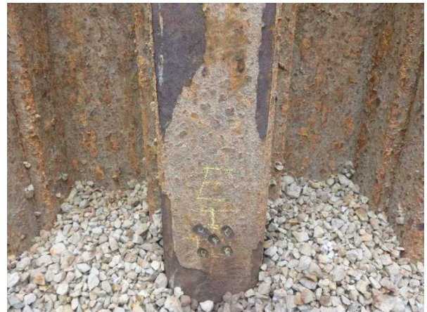
写真10 肉厚測定箇所-研磨後 (E 測線付近)
