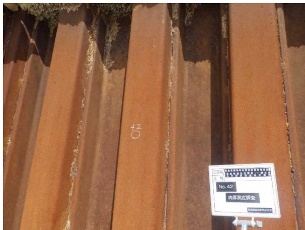
写真5 肉厚測定箇所-研磨前 (No. 42)
