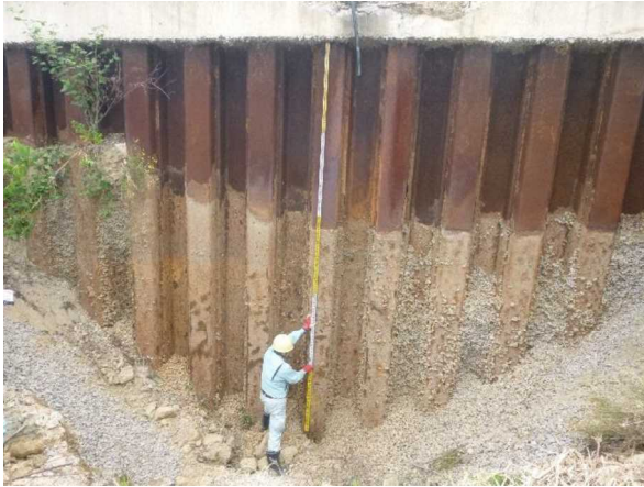
写真7 肉厚測定箇所-掘削状況 (D 測線付近)
