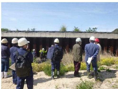
写真1 遮水壁側面部
