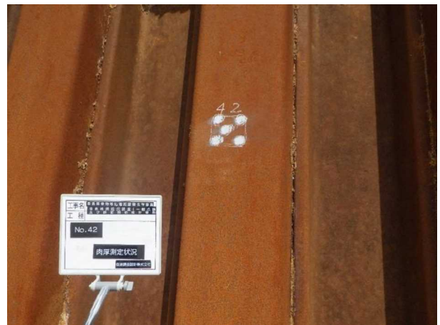
写真6 肉厚測定箇所-研磨後 (No. 42)
