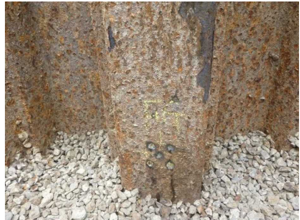
写真12 肉厚測定箇所-研磨後 (FG 中間付近)
