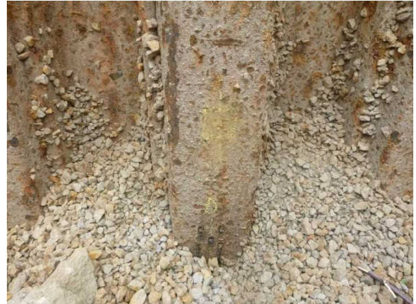
写真8 肉厚測定箇所-研磨後 (D 測線付近)
