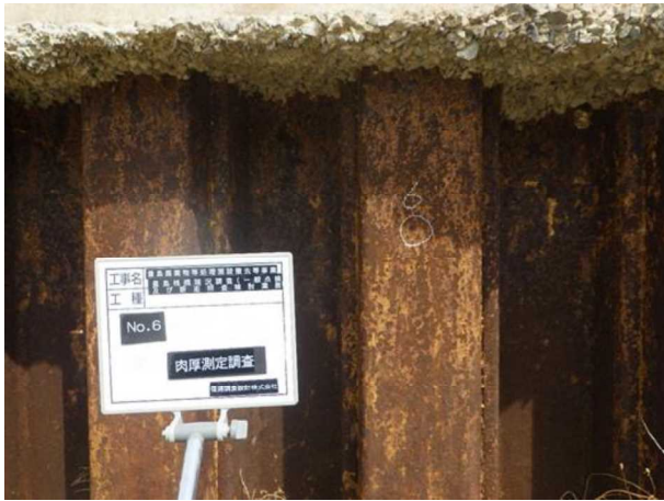
写真1 肉厚測定箇所-研磨前 (No. 6)
