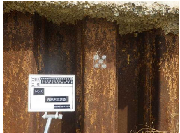
写真2 肉厚測定箇所-研磨後 (No. 6)
