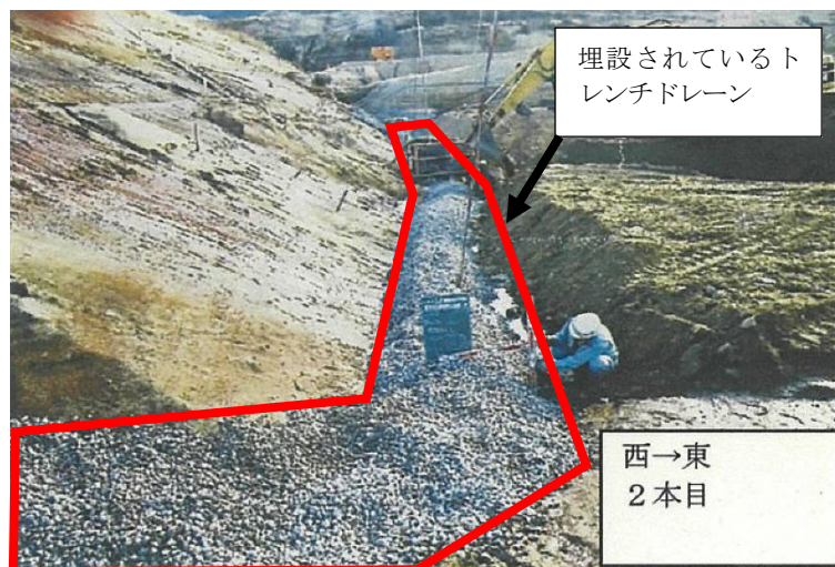
写真 1 設置当時（H12）の承水路トレンチドレーン
