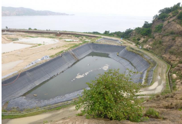
写真2 貯留トレンチ
