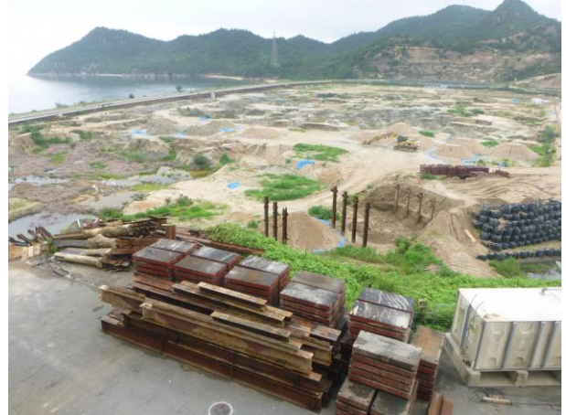
写真6 覆工板等撤去後
