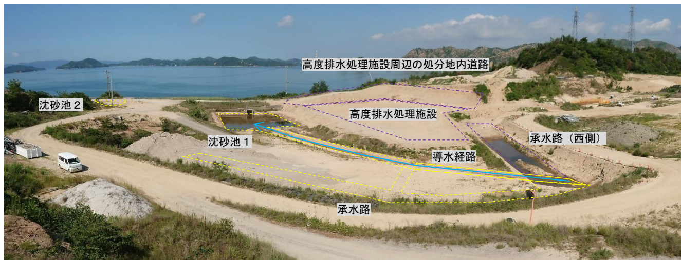
写真1 承水路の撤去後の状況
