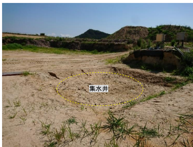
写真2 集水井の撤去後の状況
