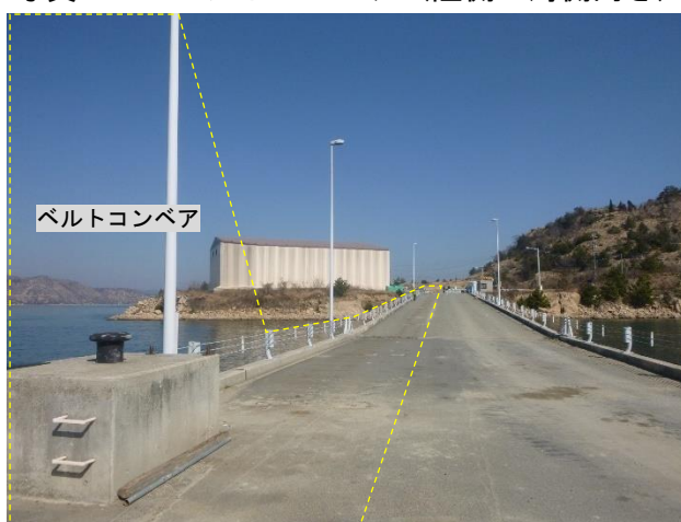
写真11 ベルトコンベア (海側→陸側向き)
