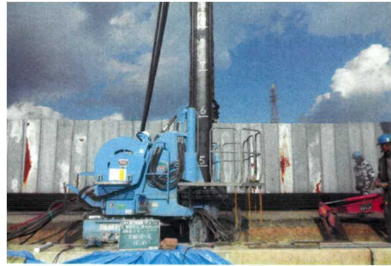
クラッシュパイラーによる圧入状況【H27北海岸トレンチドレーン撤去及び仮設矢板設置工事（第1工区）】
