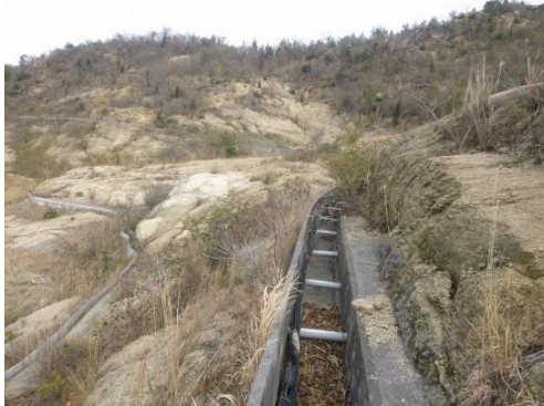
写真5 外周排水路（その1）
