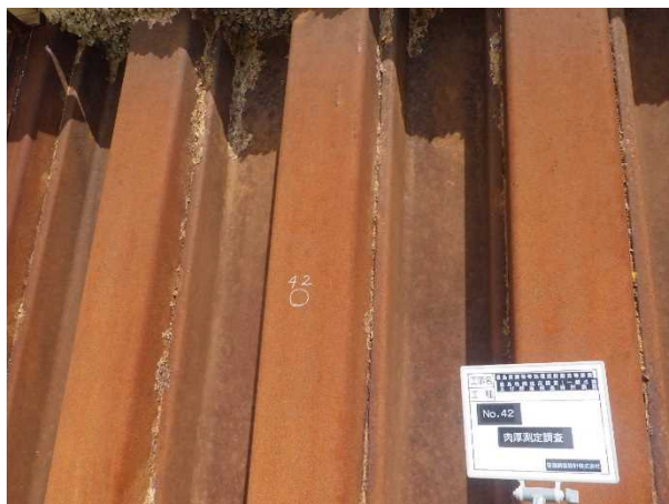
写真 5 肉厚測定箇所-研磨前 (No. 42)
