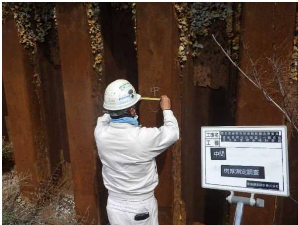
写真 3 肉厚測定箇所-研磨前 (中間)
