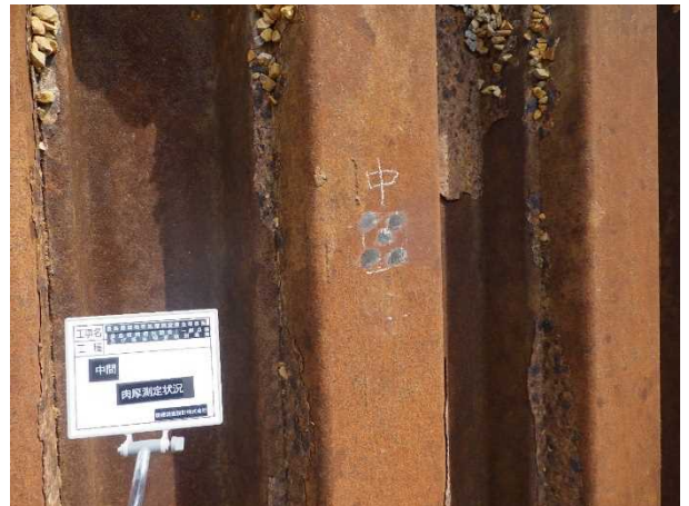
写真 4 肉厚測定箇所-研磨後 (中間)
