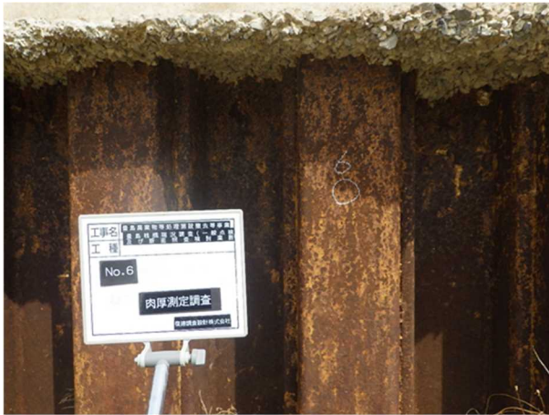
写真 1 肉厚測定箇所-研磨前 (No. 6)
