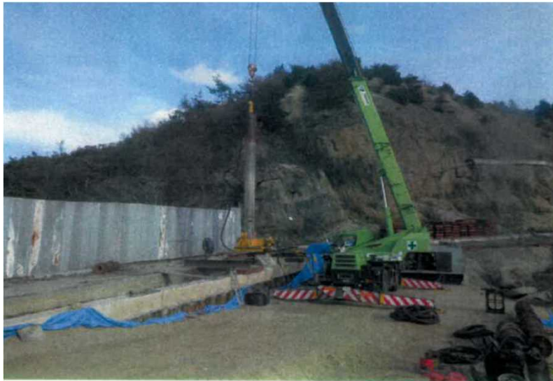
ダウンザホールハンマによる先行掘削状況【H27北海岸トレンチドレーン撤去及び仮設矢板設置工事（第1工区）】
