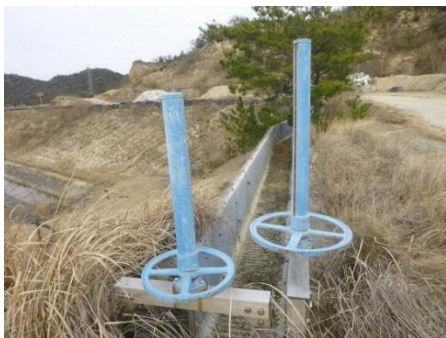
写真1 処分地進入路の排水路
