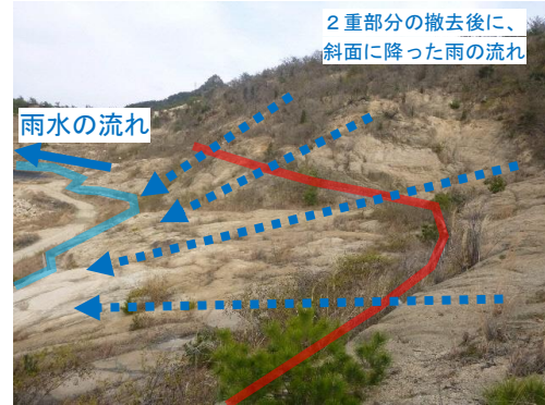
写真6 外周排水路（その2）
