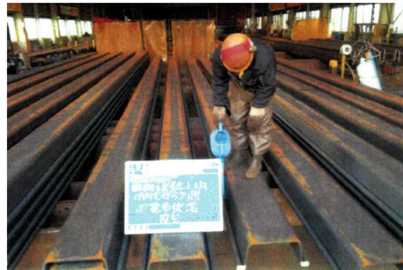
鋼矢板への止水材塗布状況【H27北海岸トレンチドレーン撤去及び仮設矢板設置工事（第1工区）】
