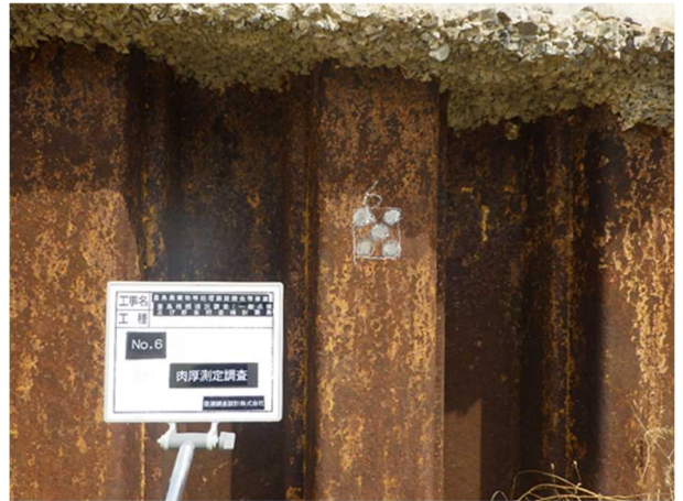
写真 2 肉厚測定箇所-研磨後 (No. 6)
