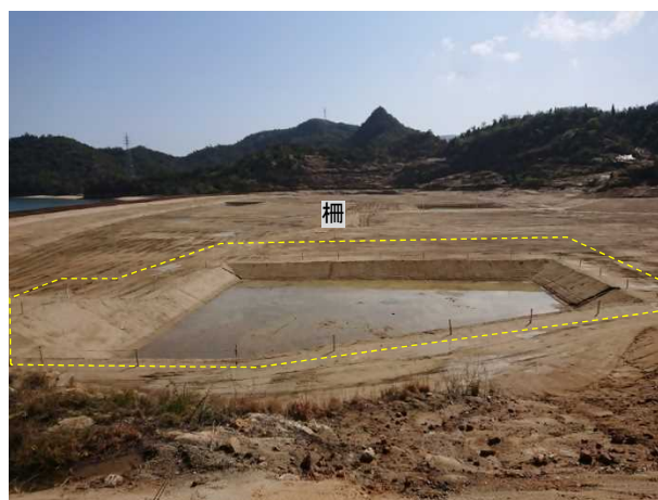
写真 14 浸透池（D 側線西側）の改修後の状況
