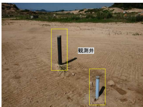
写真 3 - 1 観測井の撤去前の状況
