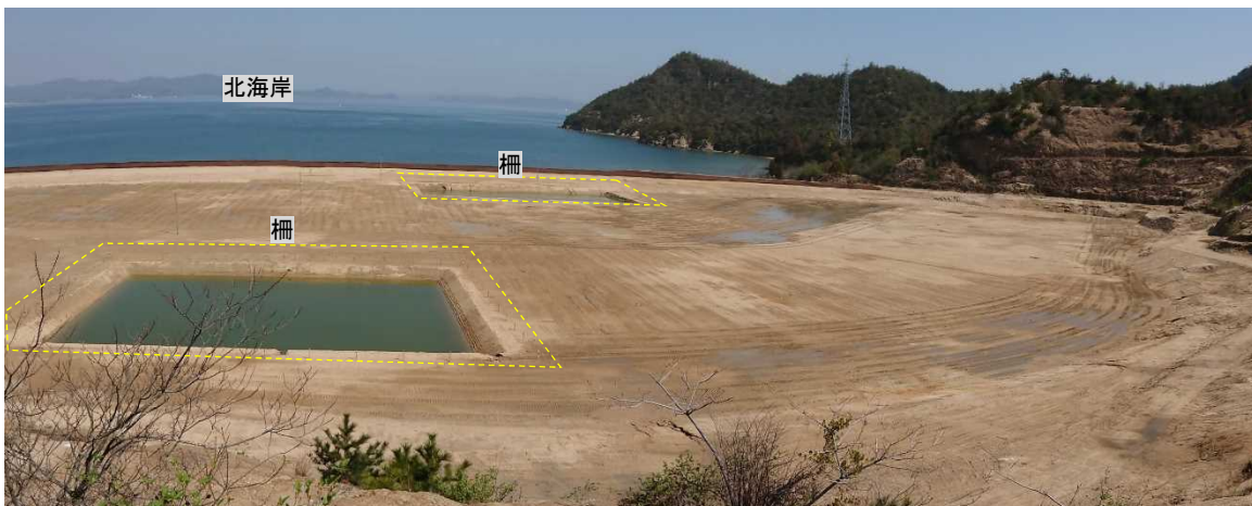
写真 11-2 処分地の整地関連工事後の状況(南側から撮影)
