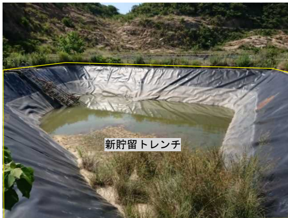
写真5-1 新貯留トレンチの撤去前の状況
