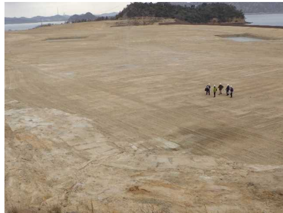
R5.3.16 現地確認（東側から撮影）
