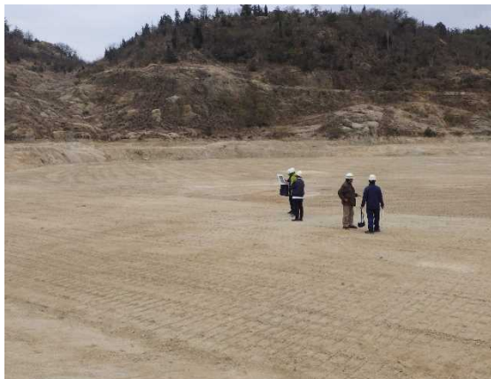
撤去後 (R5. 3. 16 現地確認)
