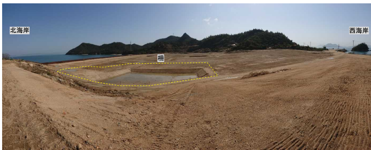
写真 12-2 処分地の整地関連工事後の状況（西側から広角撮影）
