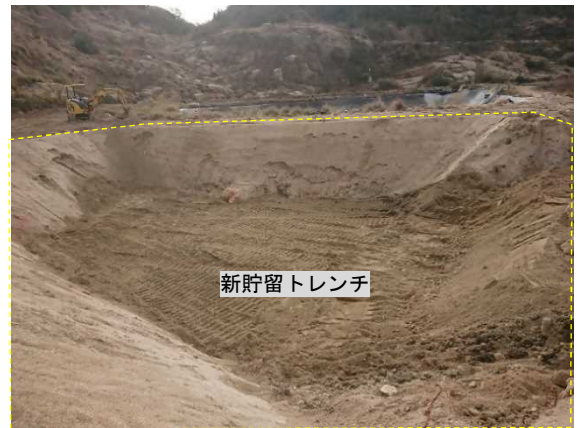
写真5-2 新貯留トレンチの撤去後の状況
