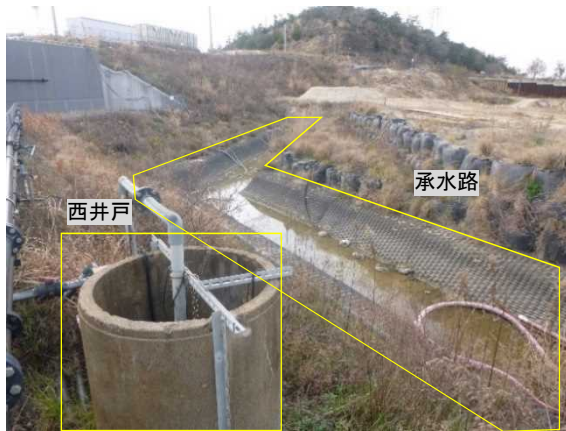
写真2 ①-2 承水路 (①-3 承水路下トレンチドレン含む) 及び①-4 西井戸の撤去後の確認状況
