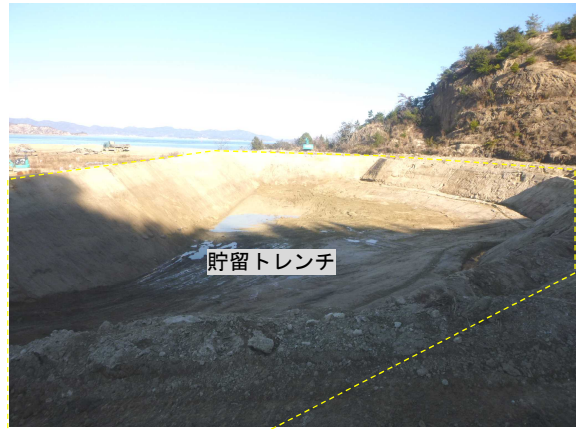
写真4-2 貯留トレンチの撤去後の状況
