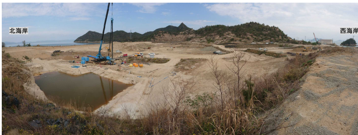
写真 12-1 処分地の整地関連工事前の状況（西側から広角撮影）
