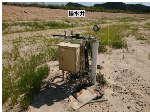
写真 2 - 1 揚水井の撤去前の状況
