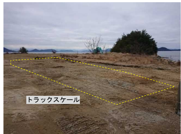
写真 9-2 トラックスケールの撤去後の状況
