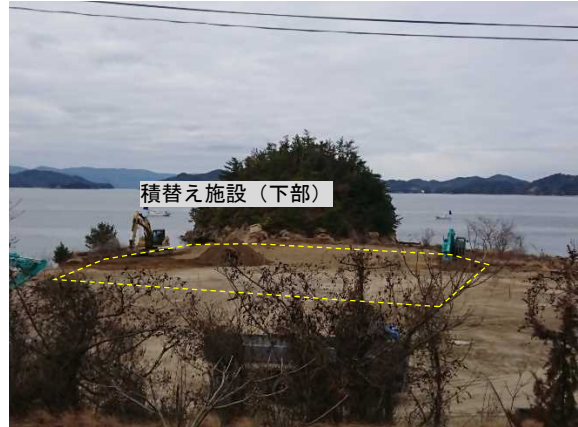
写真 8-2 積替え施設(下部)の撤去後の状況
