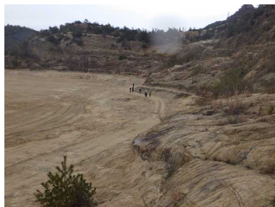
撤去後 (R5. 3. 16 現地確認)
