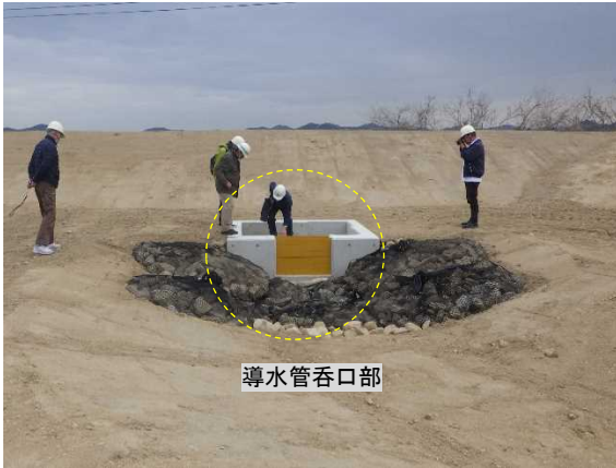
写真 21 ⑥-4-4 導水管呑口部
