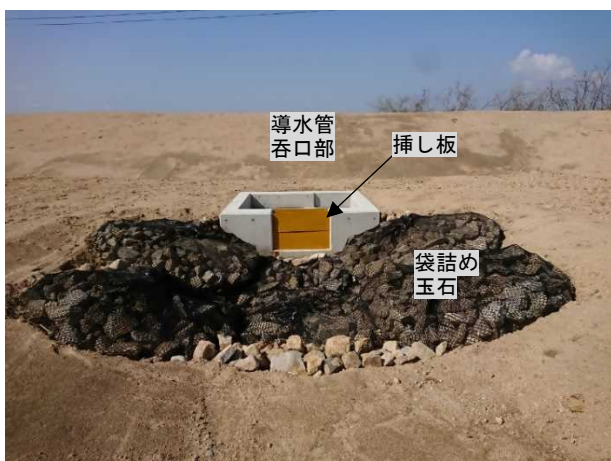
写真 13 導水管呑口部の改修後の状況
