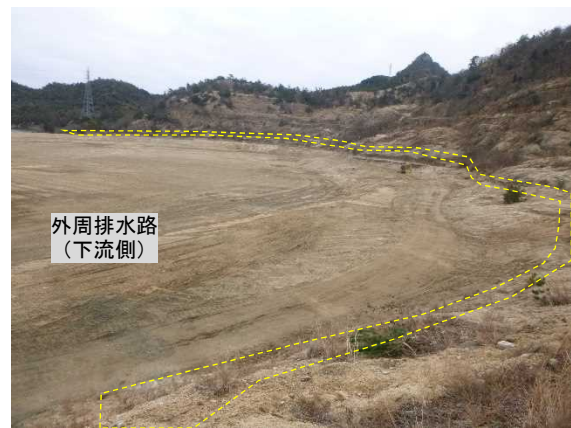
写真6-2 下流側の排水路の撤去後の状況
