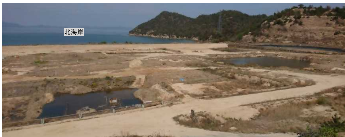
写真 11-1 処分地の整地関連工事前の状況(南側から撮影)
