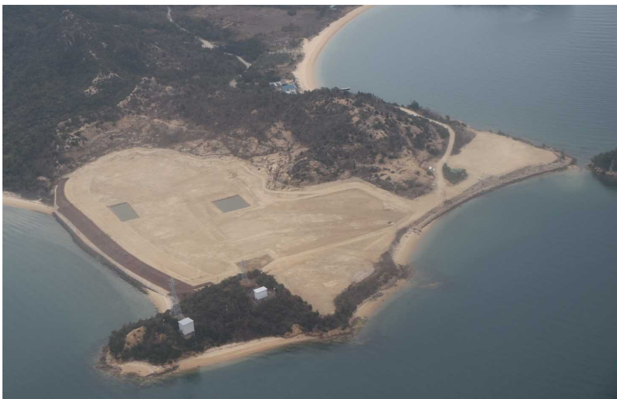
写真 28 整地後の状況（令和 5 年 3 月）
