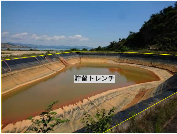
写真4-1 貯留トレンチの撤去前の状況
