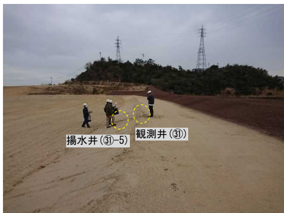
写真17 揚水井及び観測井 (区画31周辺)
