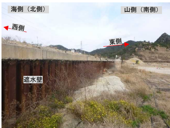
遮水壁付近撤去前 (処分地側 (東向き))
