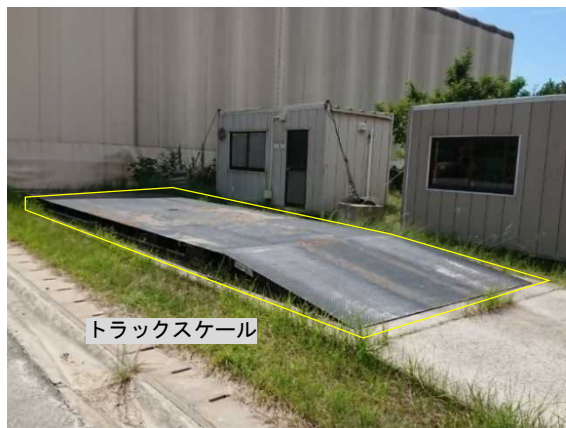
写真 9-1 トラックスケールの撤去前の状況
