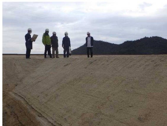
撤去後 (R5. 3. 16 現地確認)
