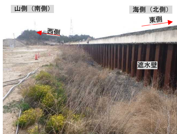
遮水壁付近撤去前 (処分地側 (西向き))
