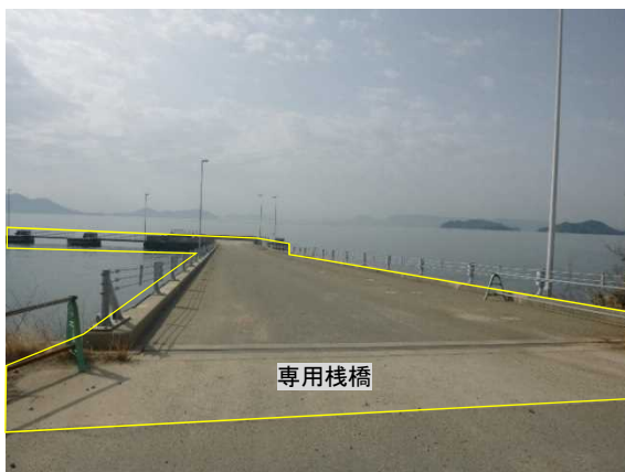
写真1-1 棧橋の撤去前の状況
