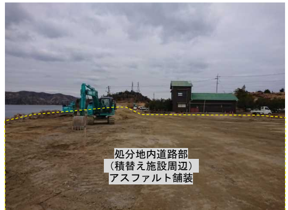
写真 10-2 処分地内道路部の撤去後の状況
