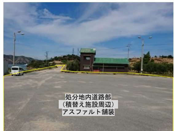
写真 10-1 処分地内道路部の撤去前の状況
