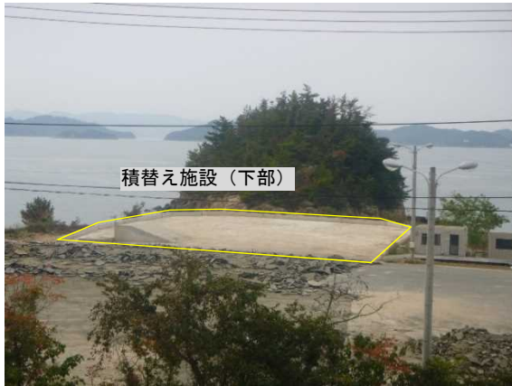
写真 8-1 積替え施設(下部)の撤去前の状況
