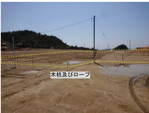
写真 25 浸透池 (木杭及びロープの設置状況)
