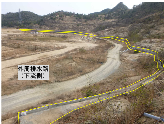
写真6-1 下流側の排水路の撤去前の状況
