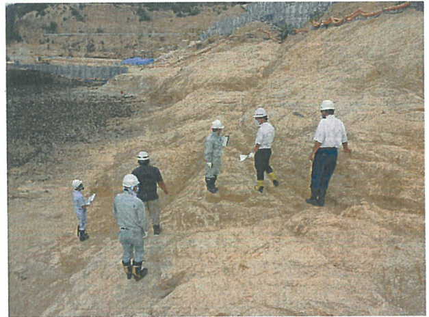
写真2 掘削完了判定 (H24. 9. 3)
