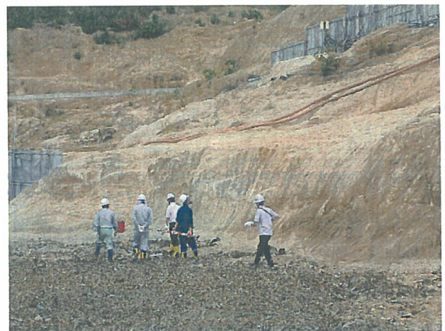
写真4 掘削完了判定 (H24. 9. 3)
