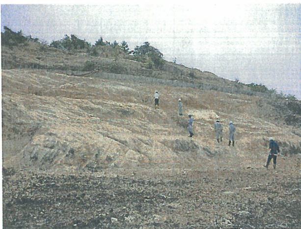
写真3 掘削完了判定調査 (H24. 9. 3)
