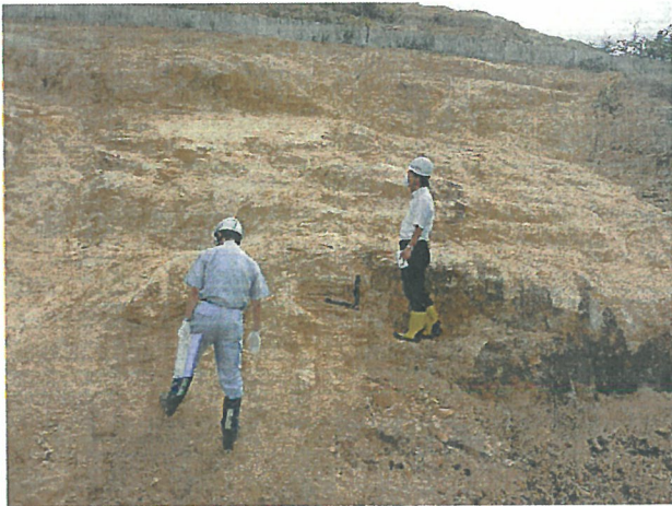
写真1 掘削完了判定調査 (H24. 9. 3)
