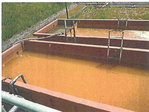
写真1 西揚水井地下水等が入った調整槽（平成24年8月8日）
