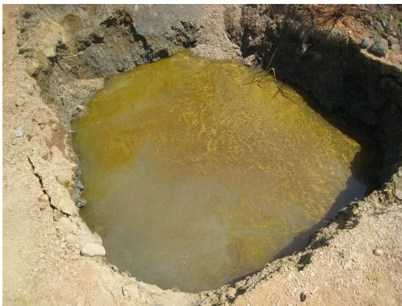
写真1 油混じり水（平成28年8月26日試掘）
