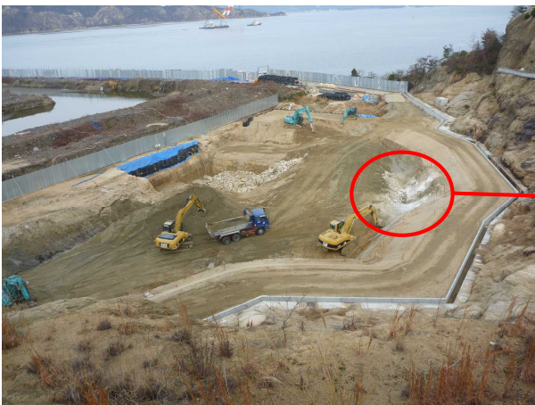
（写真1 施工状況）
