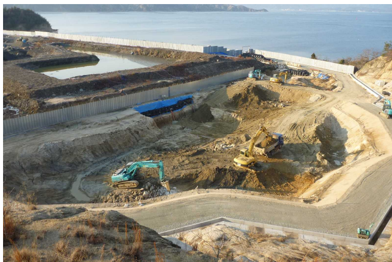
写真 H測線東側掘削状況（H25.1.8）
