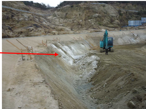
（写真2 岩盤部の状況）
