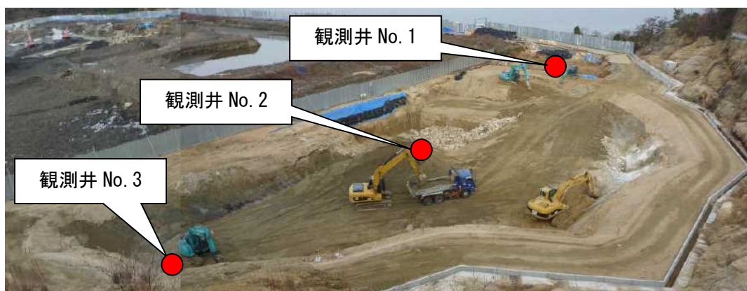
写真 観測井設置場所
