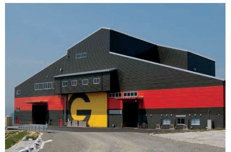
中間保管・梱包施設/特殊前処理物処理施設全景
