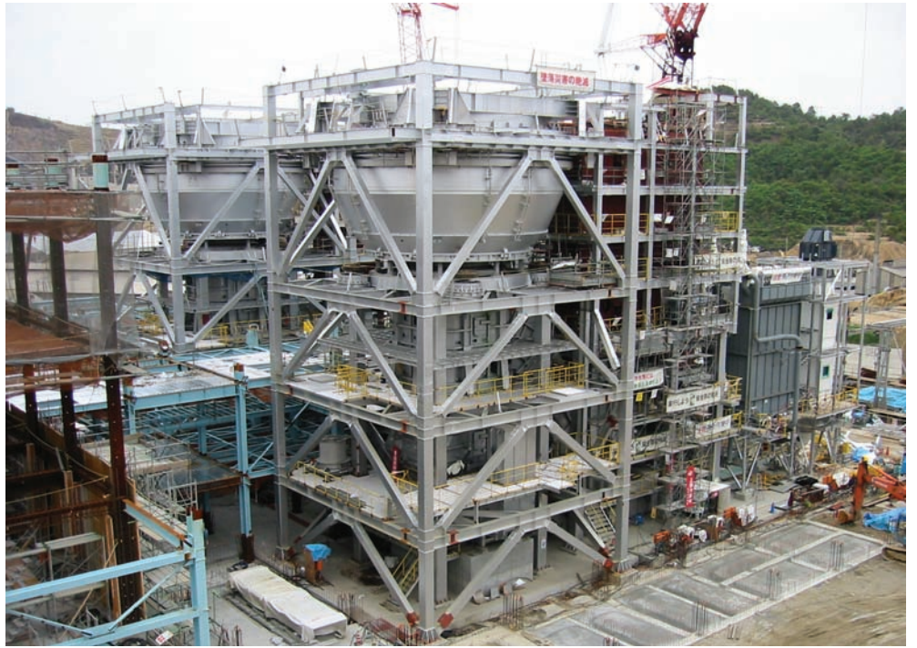
回転式表面溶融炉（工事中の写真）
