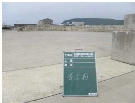
① 着工前 (南→北向き)
