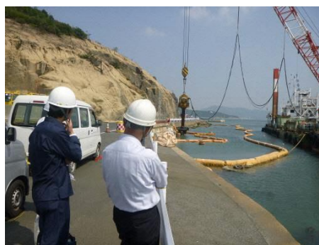
杭撤去作業の確認（南より撮影）
