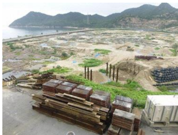
② 覆工板等撤去後
