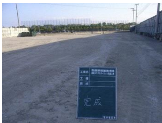
④ 完了後 (北→南向き)
