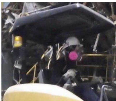
④ レベル2 保護具の着用状況 (非溶断時)
