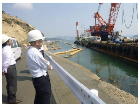
杭撤去作業の確認（南より撮影）
