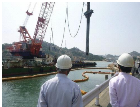
杭撤去作業の確認（北西より撮影）
