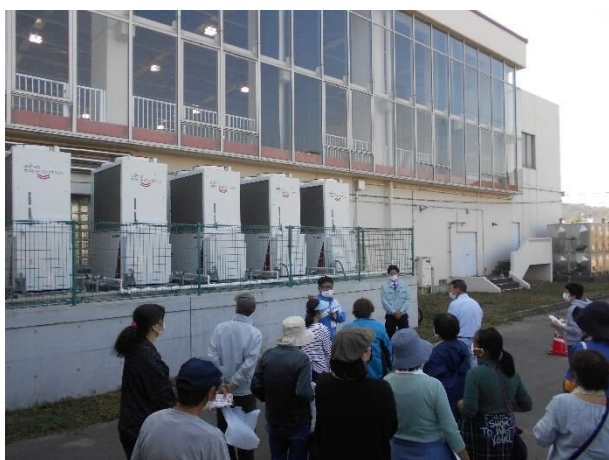
⑩体育館空調設備(四国ガス)
