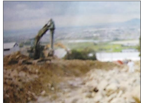
大野原町水谷川の水路啓開
