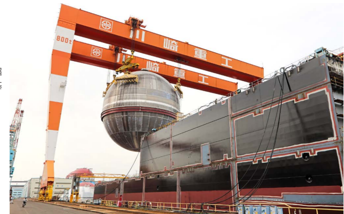
極低温に耐えるアルミ合金を使用した直径40mを超える巨大なタンクは組み立ての後、大型クレーン2基により船上に搭載される。
